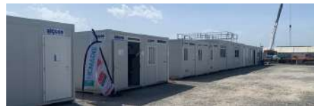
Base de vie installée à Lacq
