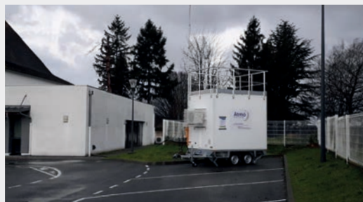
La station PTR-MS installée sur la commune d'Arance, à proximité de la Mairie. ▲
