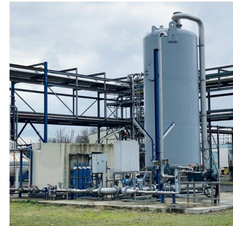
l'envoi d'effluents à la torche. Ce dispositif a démontré son utilité en 2021 avec plus de 3 300 heures de fonctionnement ; Lubrizol travaille maintenant à sa pérennisation.
